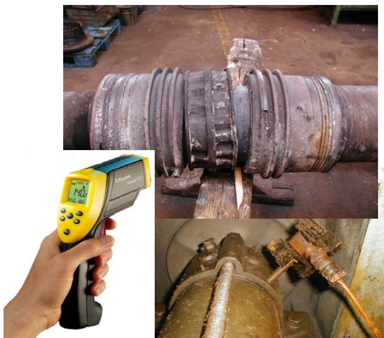
Obr. 5 Vysoká teplota, voda a znečistenie maziva je príčinou straty mazania a vážneho poškodenia
